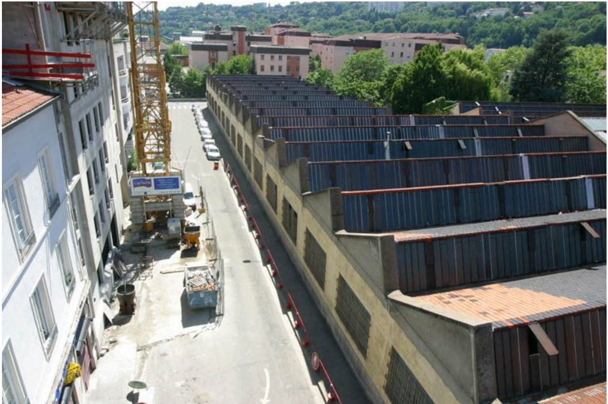
Vue nord, détail aérateur
