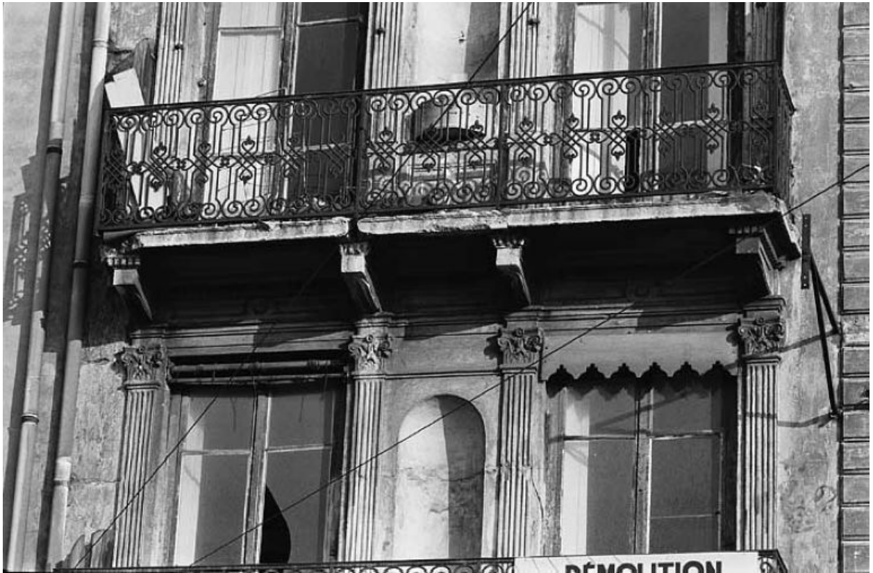
Façade sur le quai, détail du balcon du niveau 4
