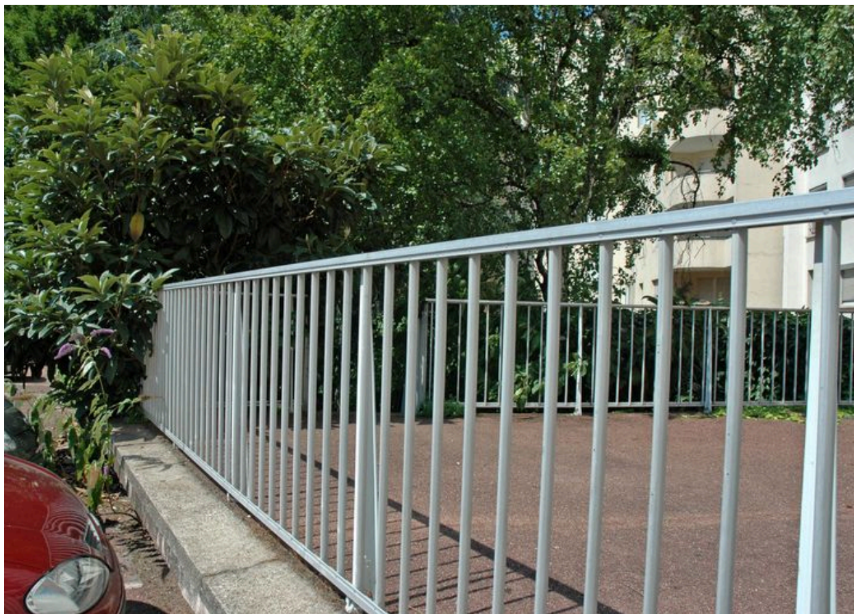
La barrière délimitant la cour de l'immeuble du parc de stationnement situé parcelle AE 6
