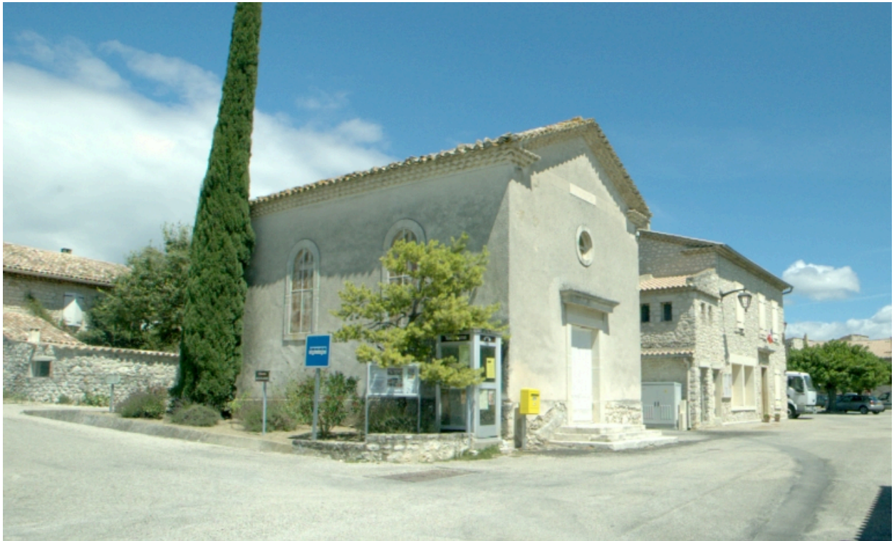
Le temple, à l'entrée sud-ouest du village, vue d'ensemble..
