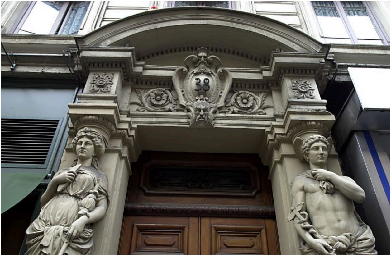
Façade principale, partie supérieure de la porte
