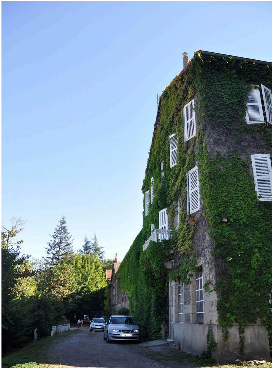
Vue d'ensemble du bâtiment
