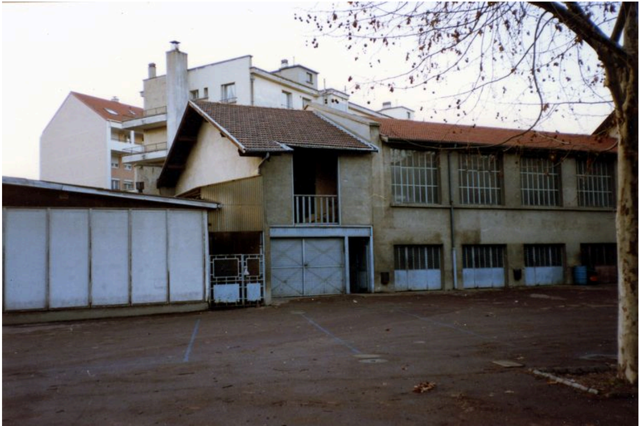
Vue de la modèlerie depuis la cour, avant les travaux, 1992
