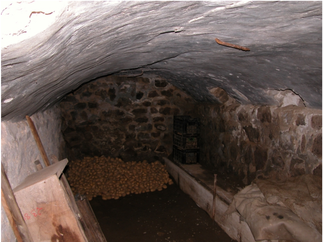
Vue intérieure de la cave à pommes de terre (ancienne cave à fourmes ?).
