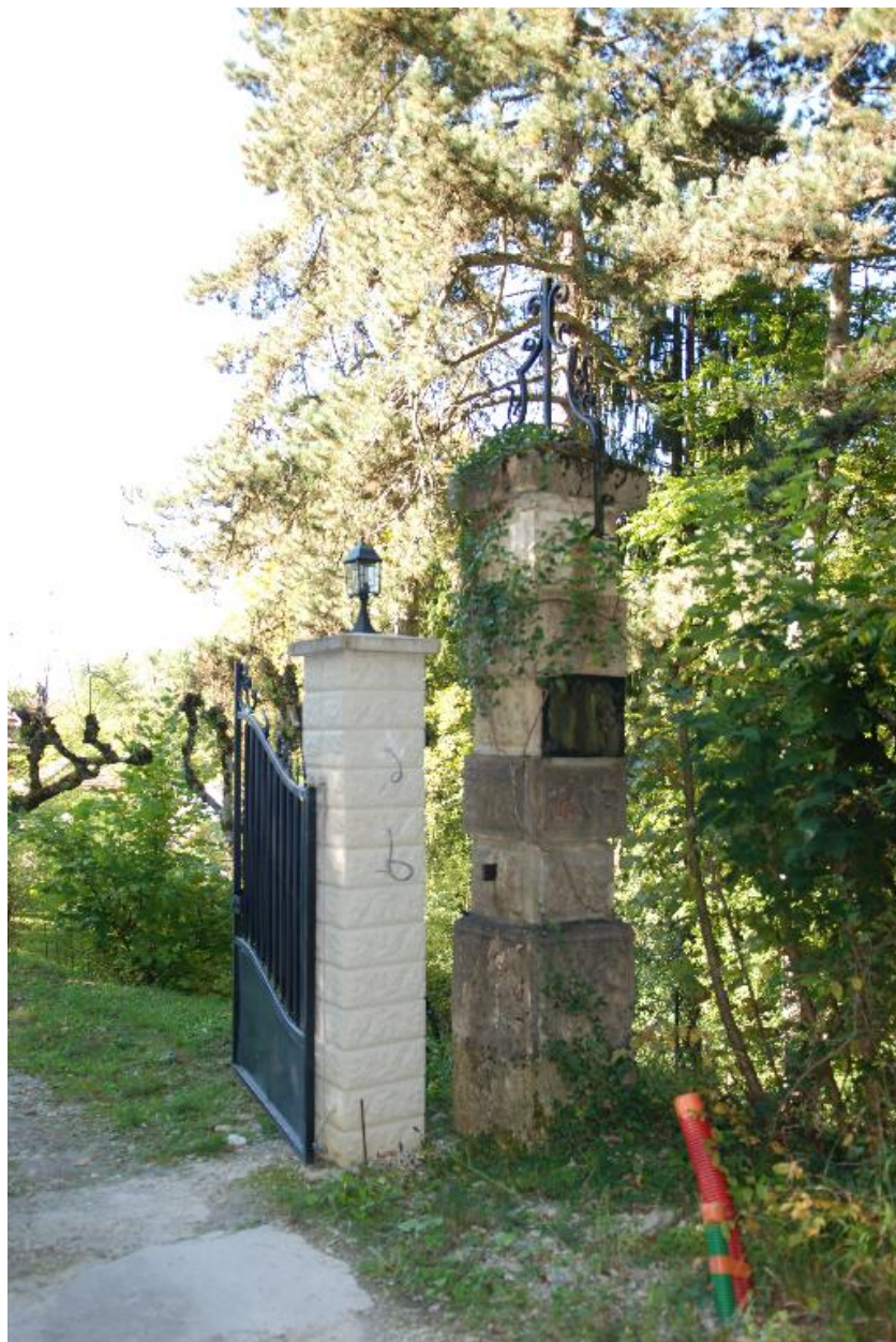
Détail d'un piédroit de l'ancien portail d'entrée du domaine.
