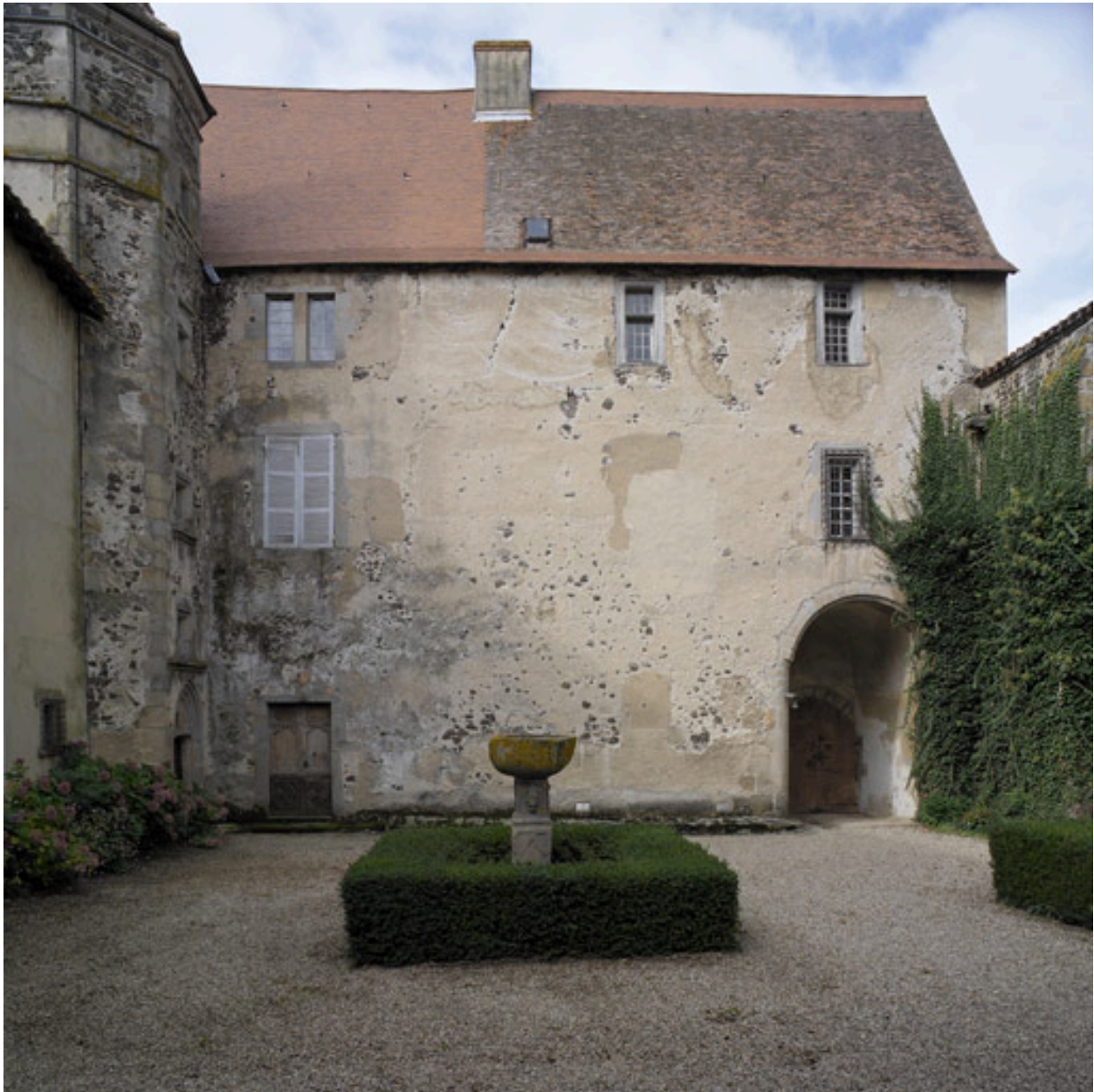
Vue de l'aile ouest (façade sur cour), depuis l'est.
