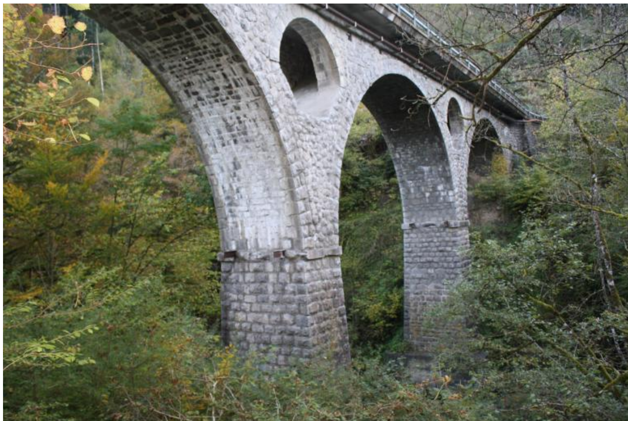
Pont de la Tassonnière, face aval
