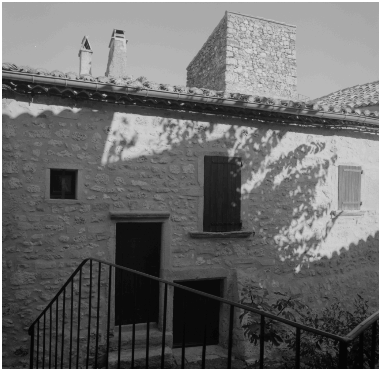
Maison, montée Saint-Roch (A 675), vue partielle de l'élévation principale ; dates gravées sur les linteaux des fenêtres.
