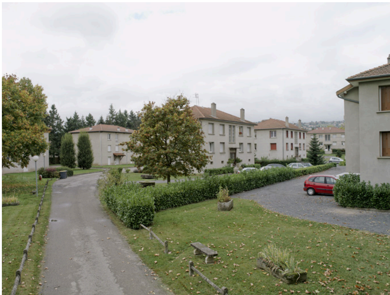
Vue d'ensemble depuis l'est de la cité ouvrière.
