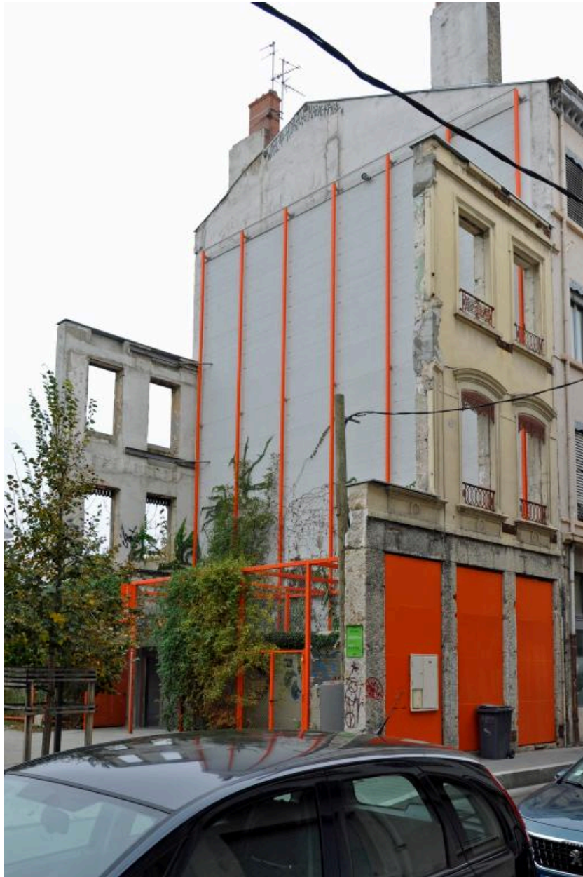
Vue d'ensemble des vestiges depuis la rue Montesquieu (2019)
