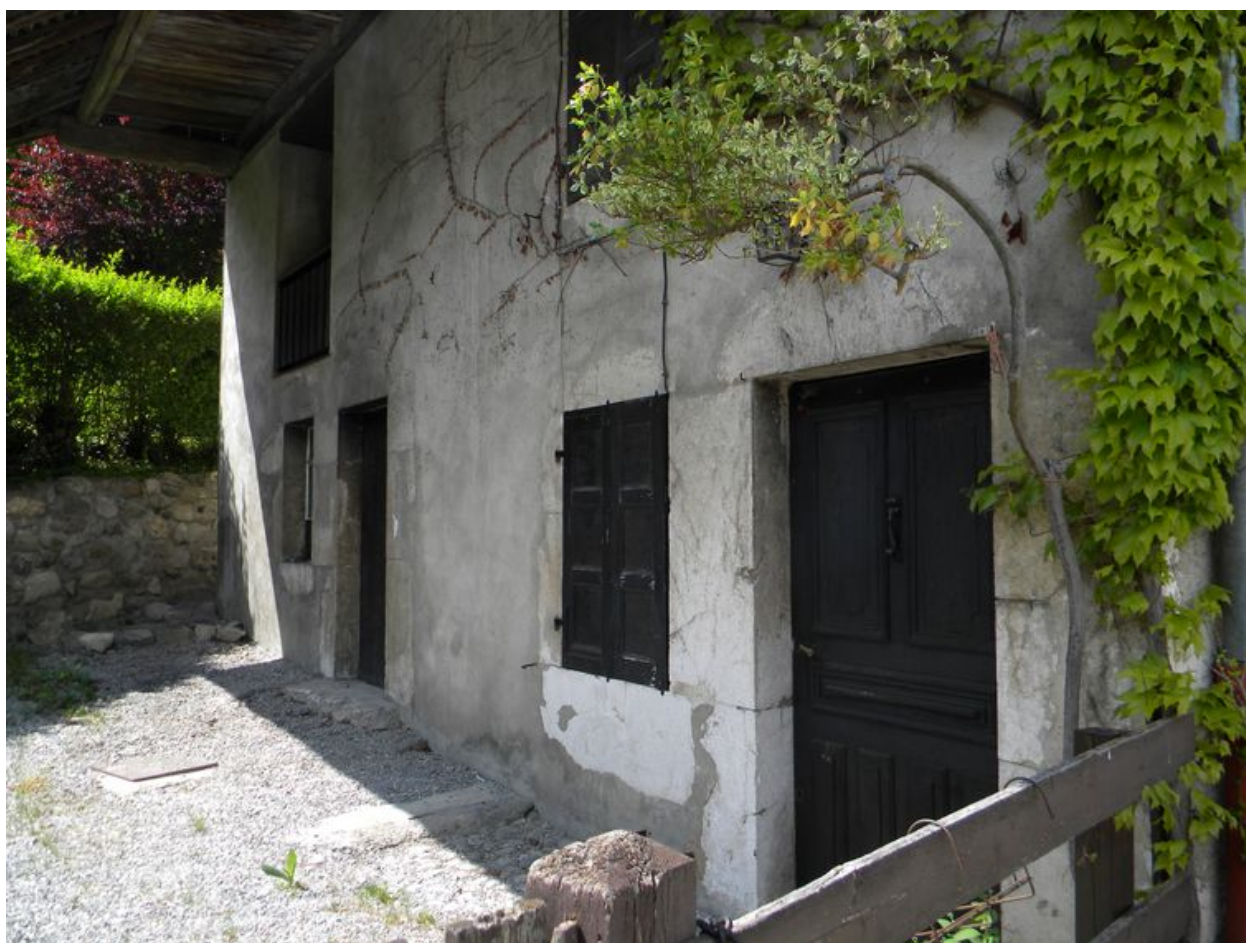
Façade sud avec partie agricoles d'une ferme bourgeoise (2008 A3 330, 328, 2437).
