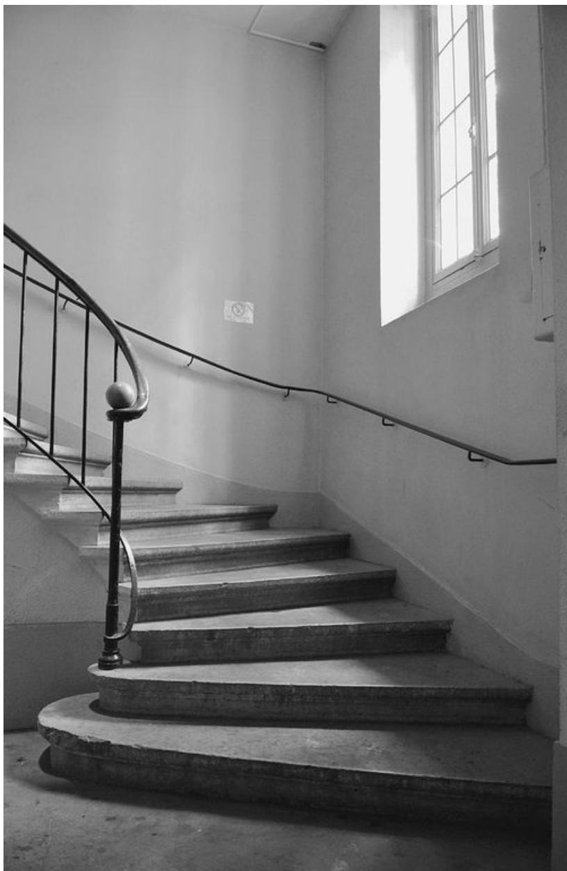
Escalier : départ de rampe.
