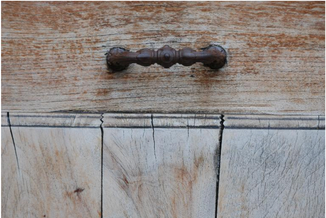
Céteil d'un vantail de la porte (poignée en fonte, assemblage des panneaux).
