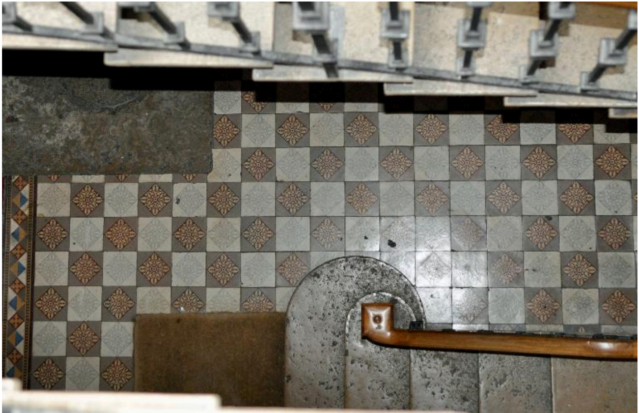
Détail du pavement de la cage d'escalier
