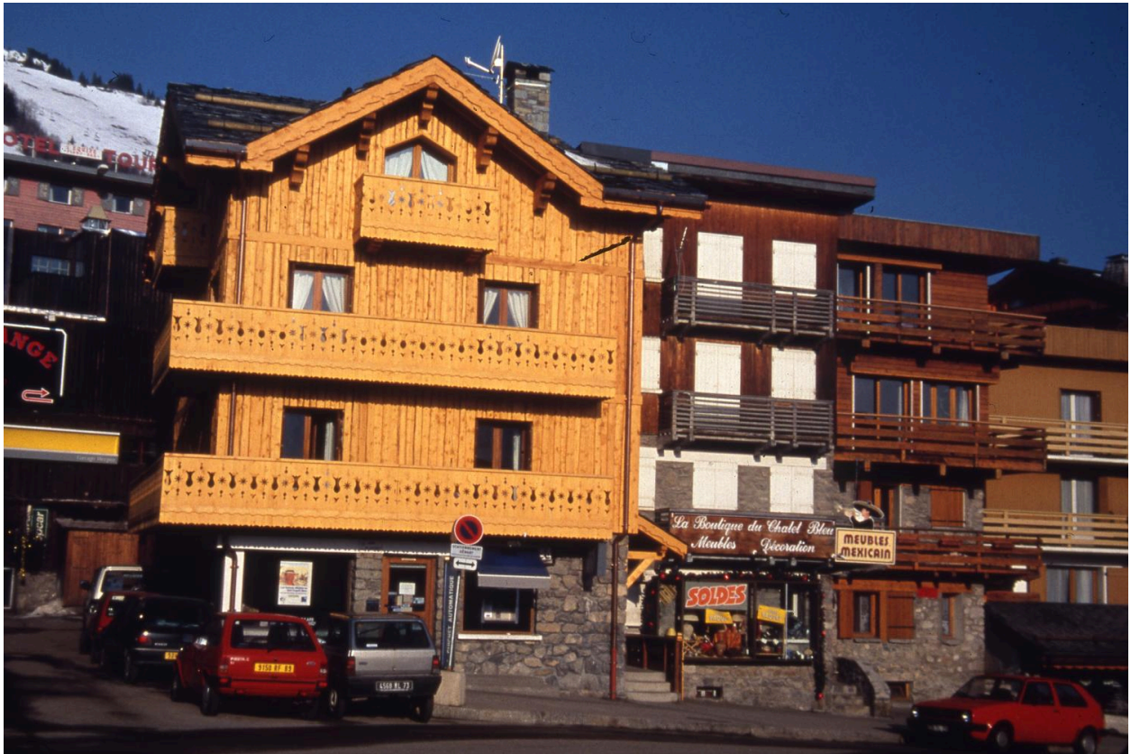
Élévation sud après les travaux
