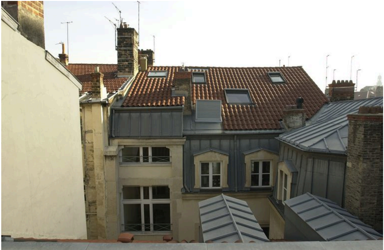
Etage de comble et toiture du corps de bâtiment sur rue depuis l'escalier de l'immeuble sis 10 rue de l'Ancienne-Préfecture
