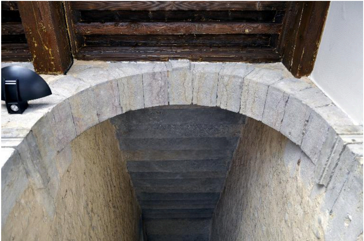
Escalier D, 3e volée : marques de tâcheron sur le plein cintre
