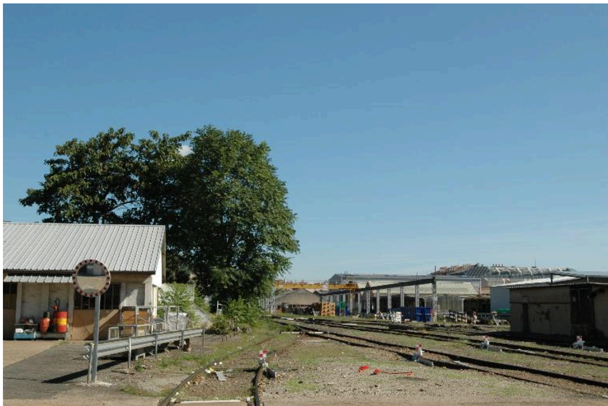
Vue extérieure du site
