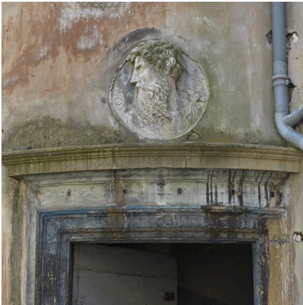
Linteau de la porte de la tour d'escalier
