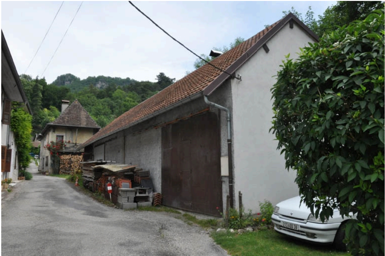
Vue générale, façades ouest et nord
