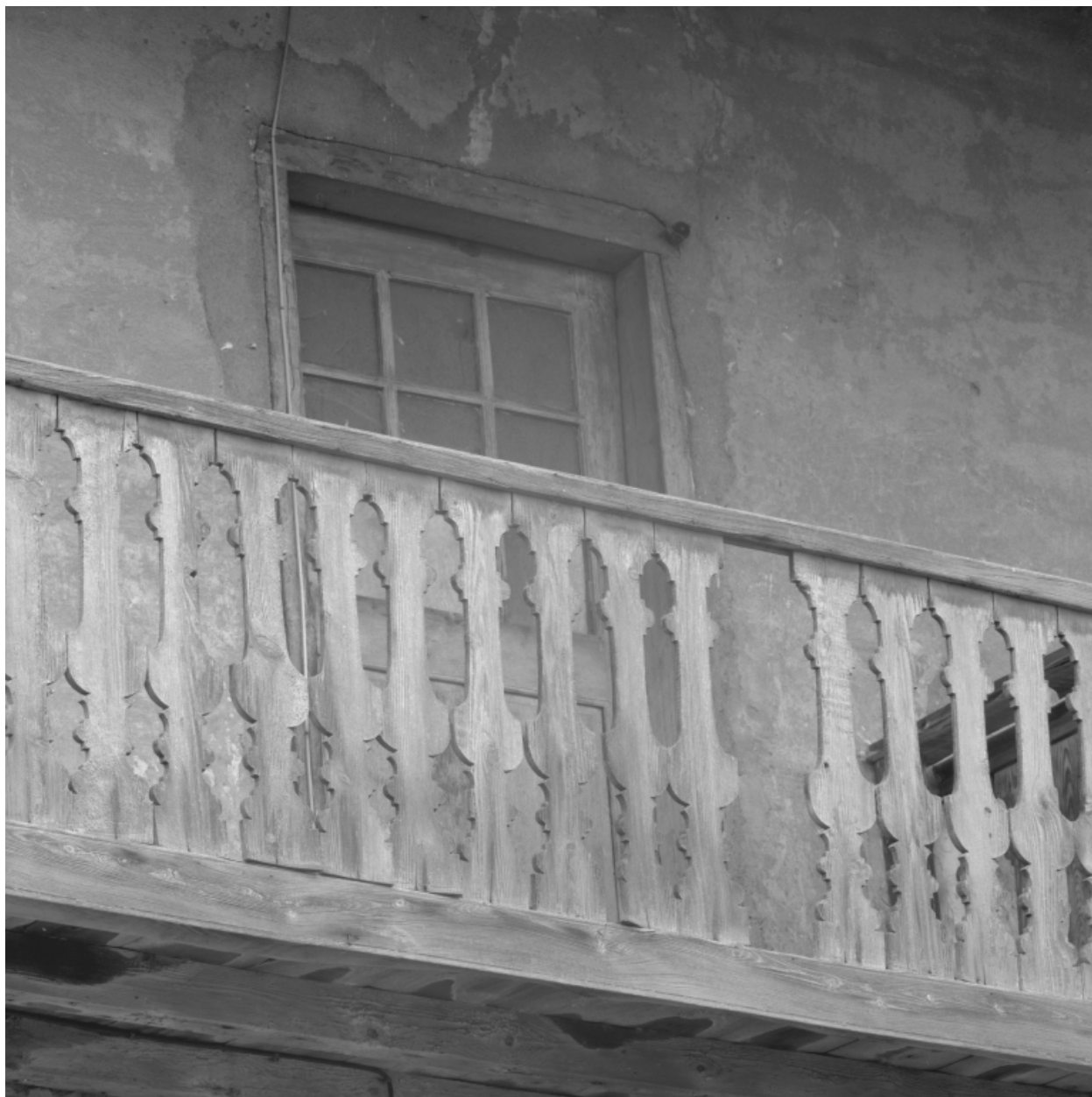
Détail du garde-corps de la galerie, au 2e étage.
