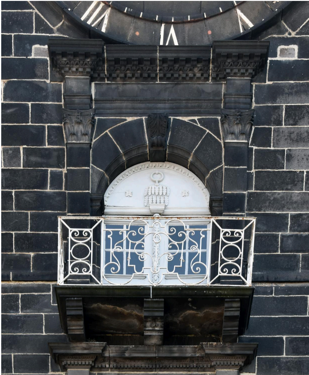
Pavillon central : détail de la fenêtre du 3e étage
