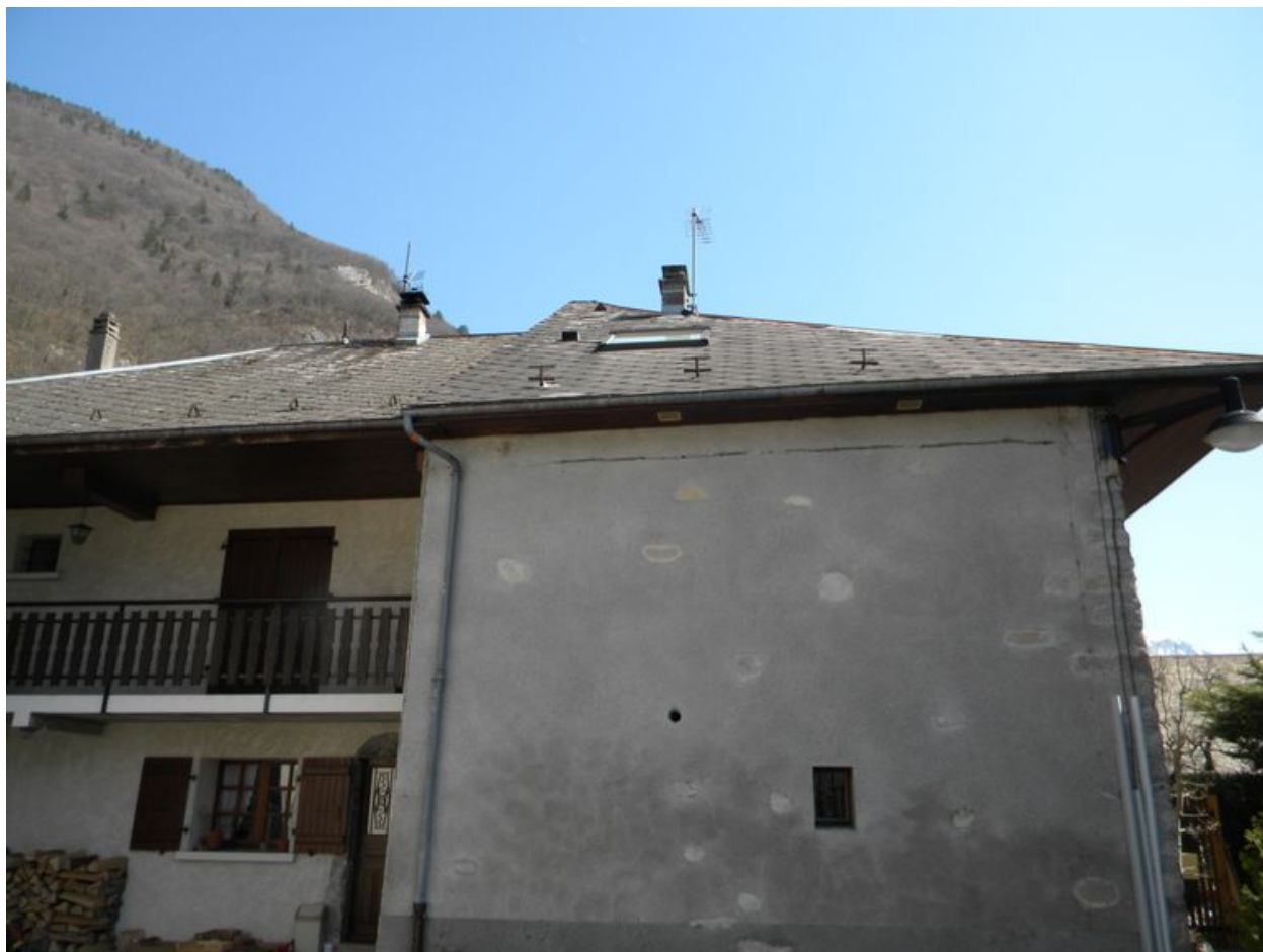
Vue de la façade ouest.
