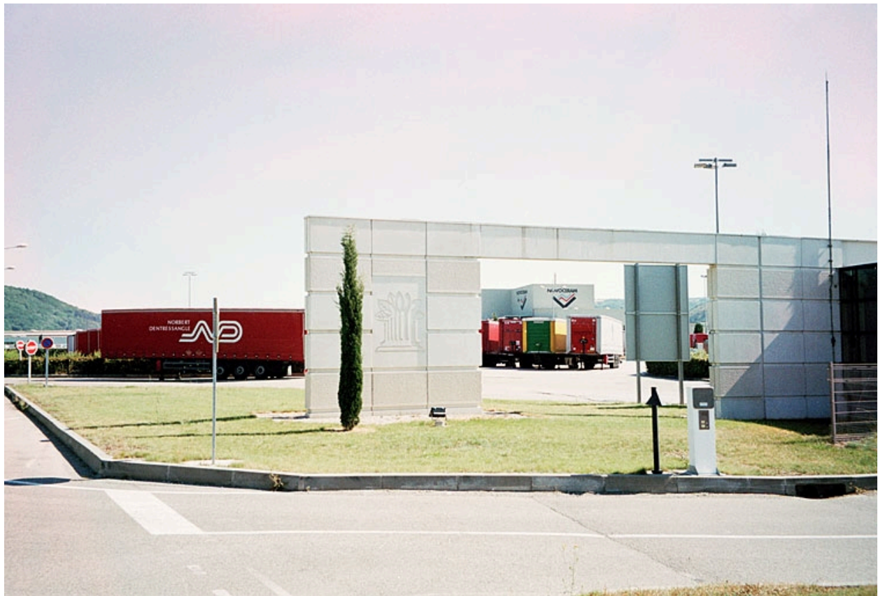
Enseigne, parking des camions
