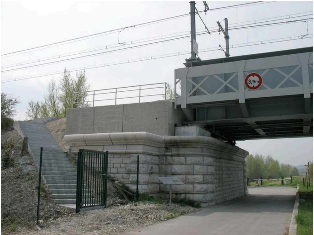
Vue de la culée rive gauche, conservée dans l'ouvrage actuel
