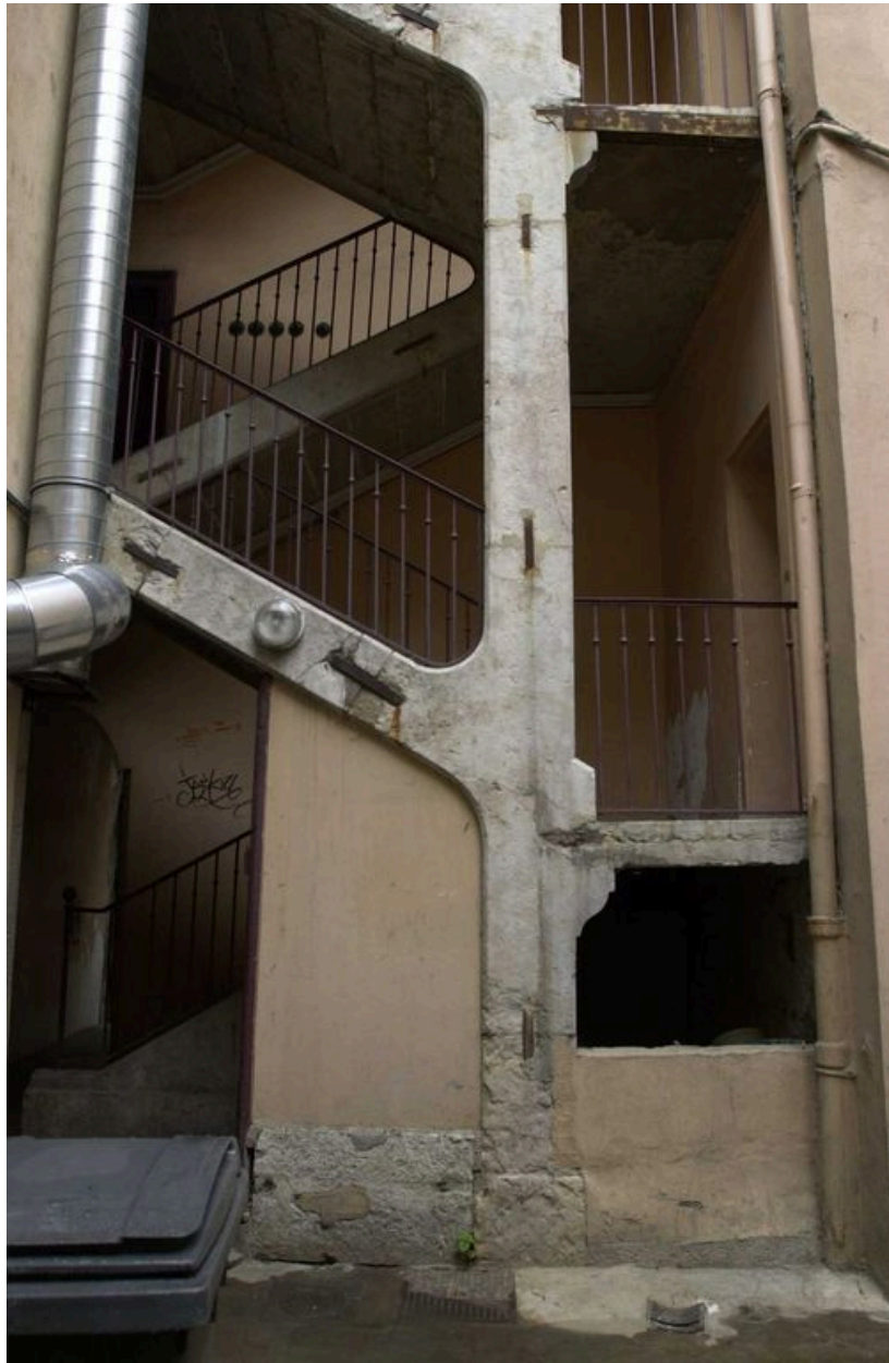
Détail de la cage d'escalier depuis la cour
