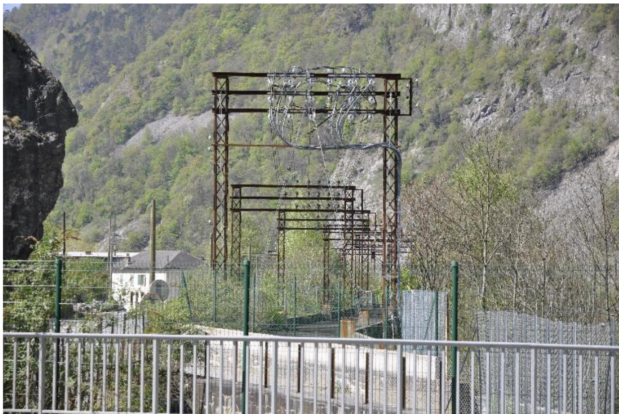
Vue du barrage
