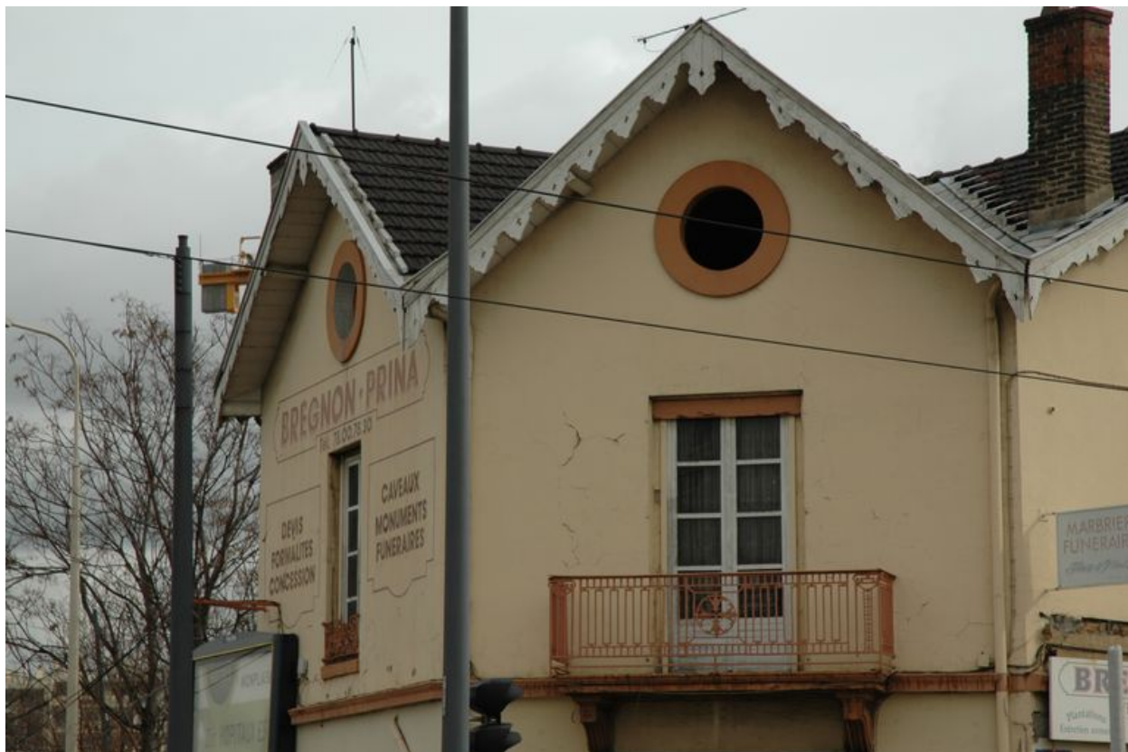
Détail de la façade à l'angle de l'avenue Berthelot et du boulevard des Tchécoslovaques
