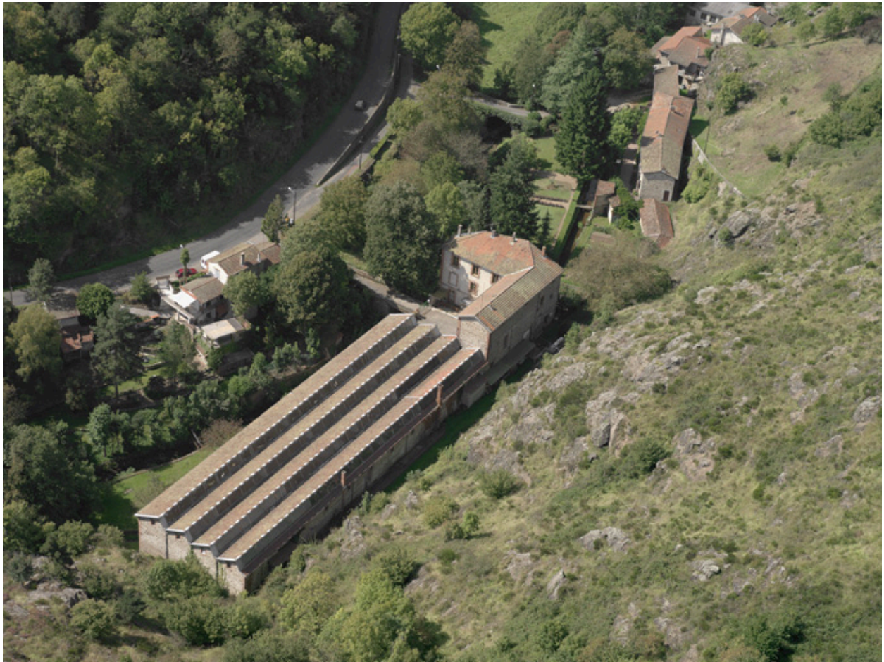
Vue d'ensemble aérienne depuis le nord-est.
