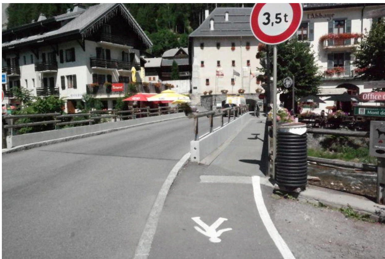
Ancien pont couvert d'Abondance, vue de la chaussée en aval depuis la rive gauche
