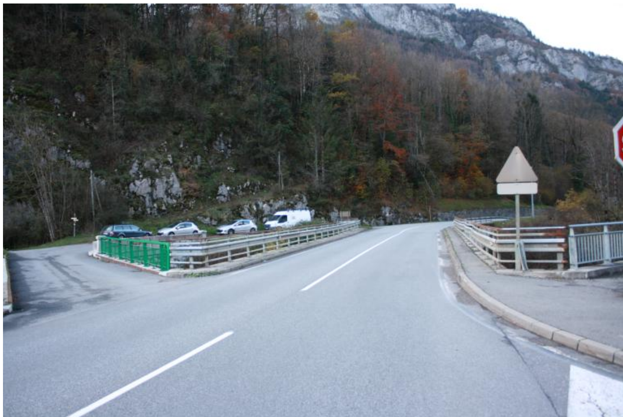
Pont de Gys, cjaussée et gardes corps
