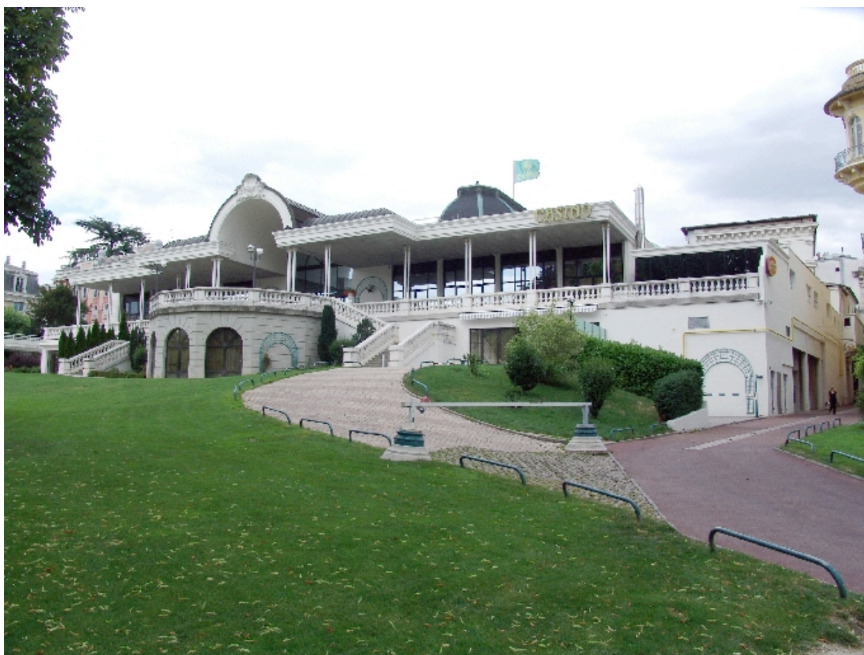
Façade ouest sur jardin
