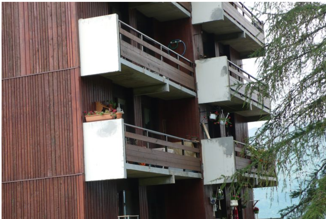
Détail des balcons
