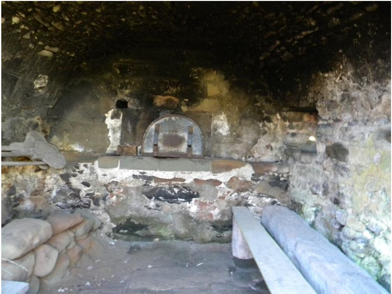
Vue du auvent avec l'entrée de la chambre de cuisson.
