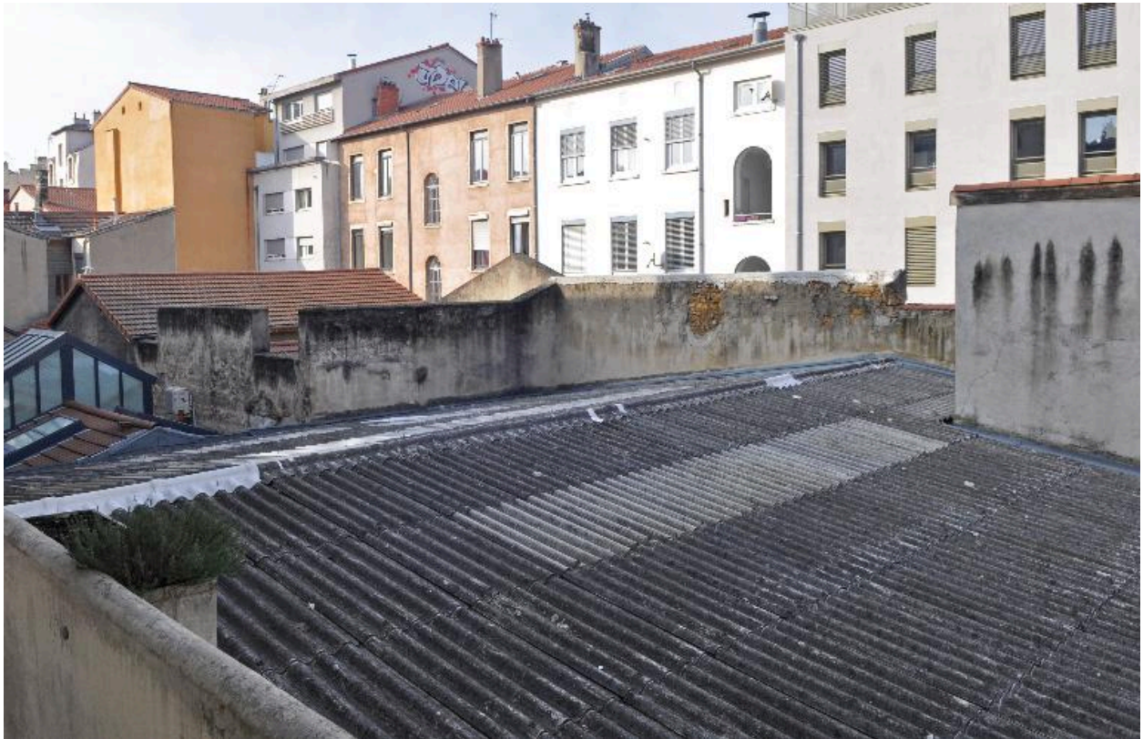
Hangar occupant le fond de parcelle
