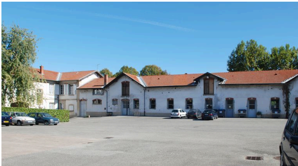
Bâtiment 232, ancienne vacherie : façade ouest
