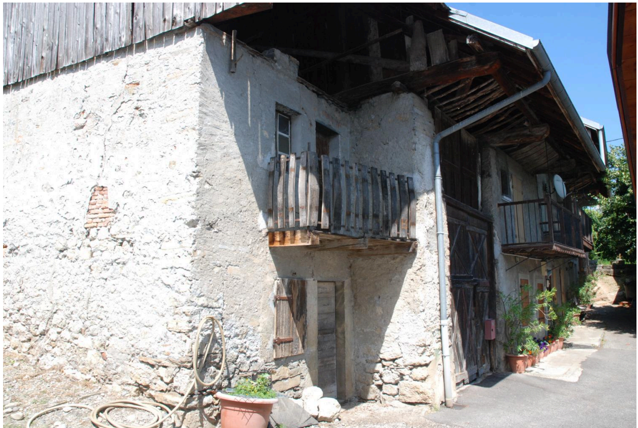
Maison de vigneron (ancien cellier) et ferme à juxtaposition (les Allues-dessous, 2018 YE 139 et 140).
