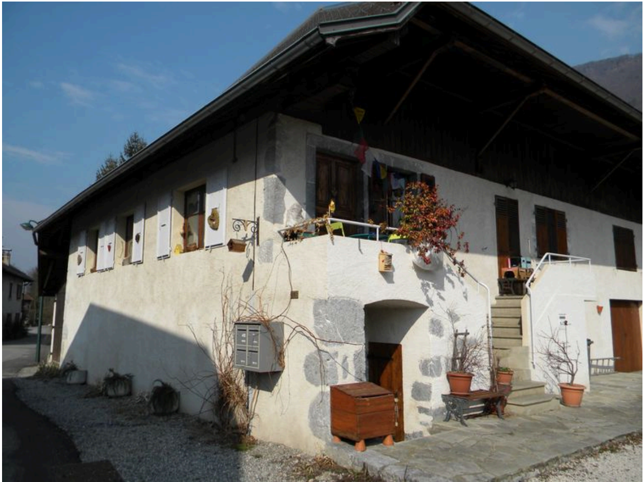
Vue de trois-quarts avec la montée d'escalier extérieur en pierre.
