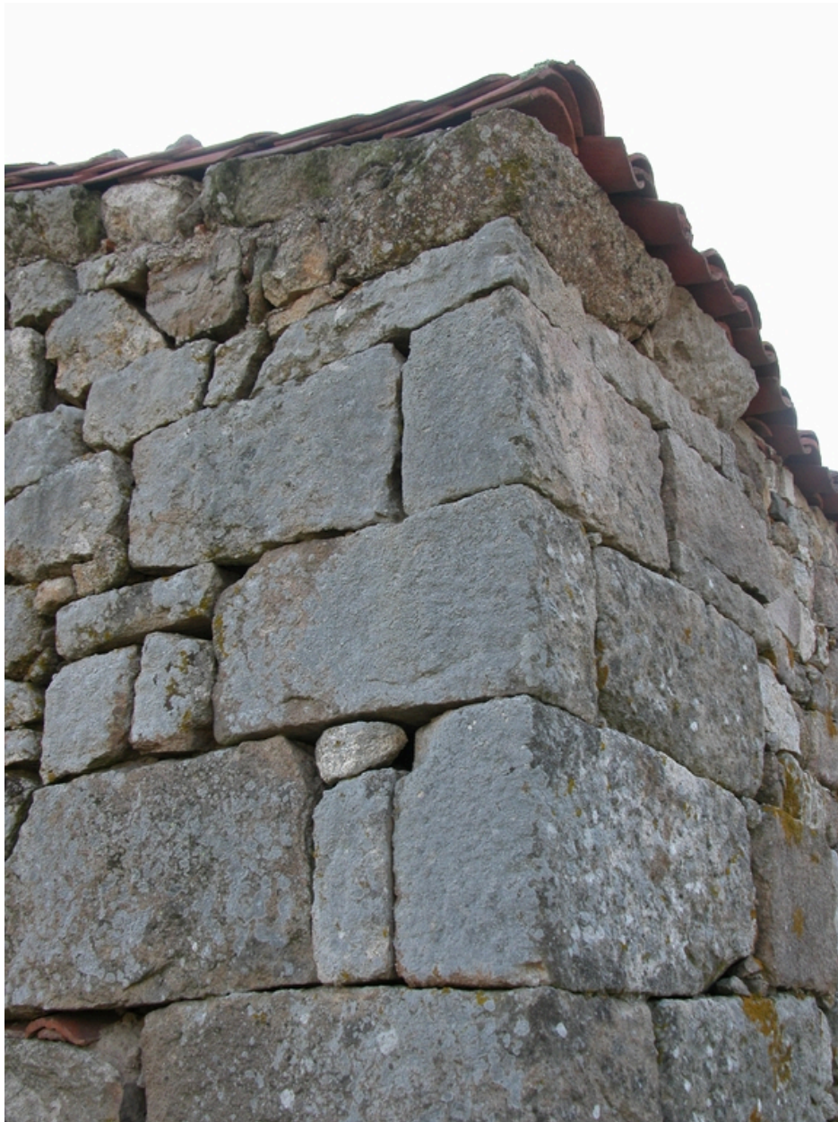
Détail de l'appareillage du sommet de l'angle nord-est du logis.
