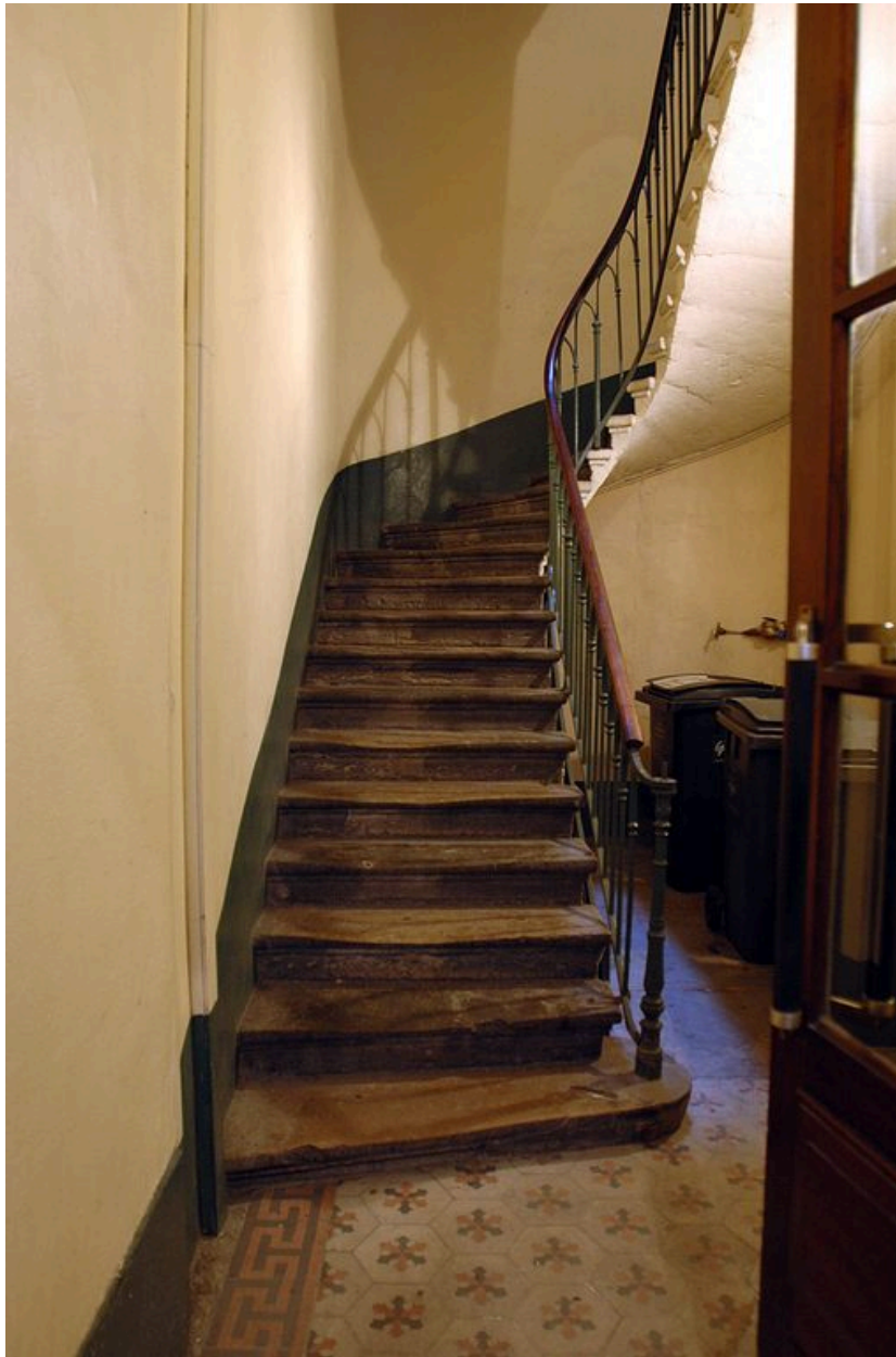
Départ d'escalier et revêtement de sol
