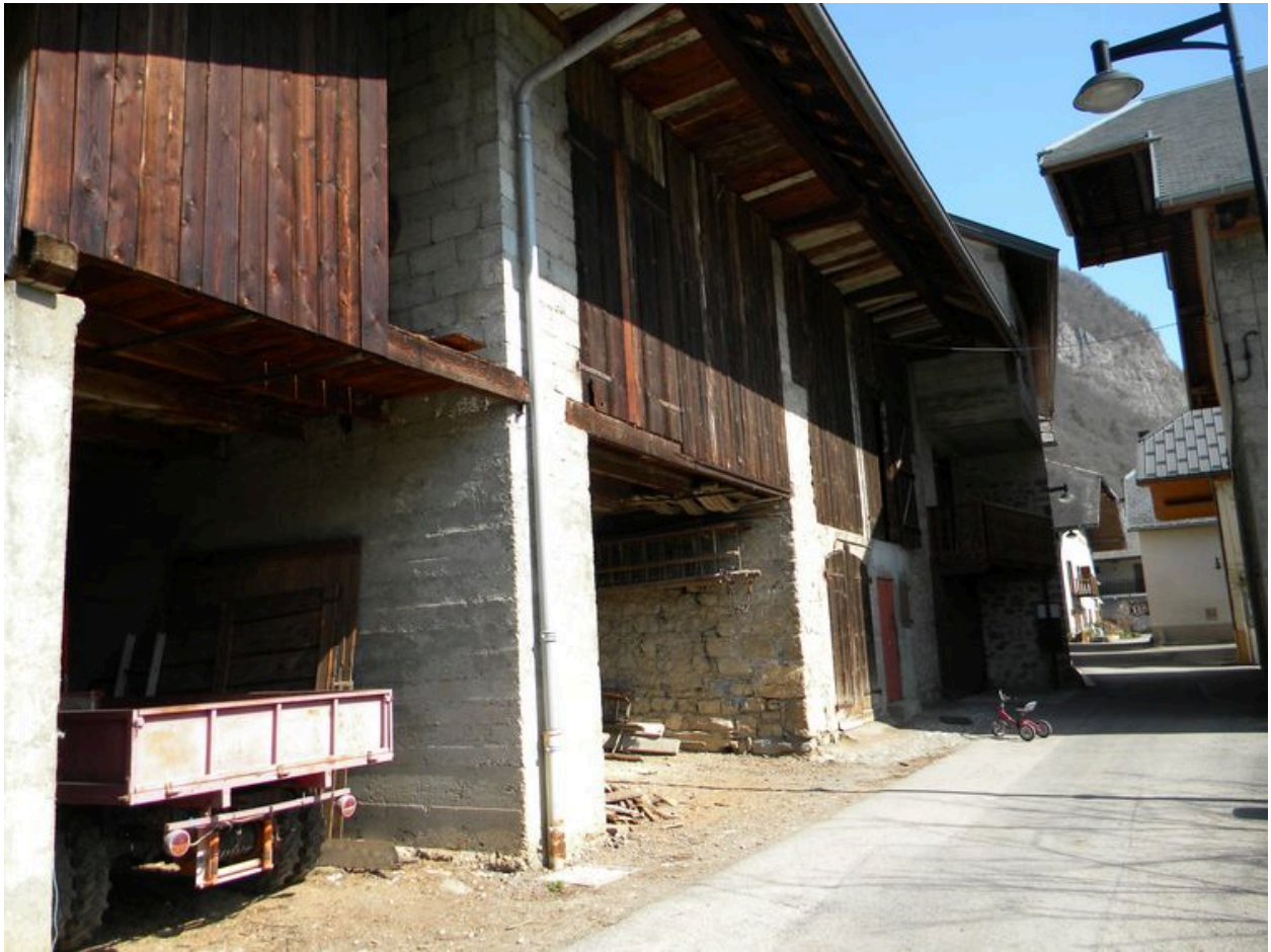
Façade d'un bâtiment agricole (A2 388, 389).
