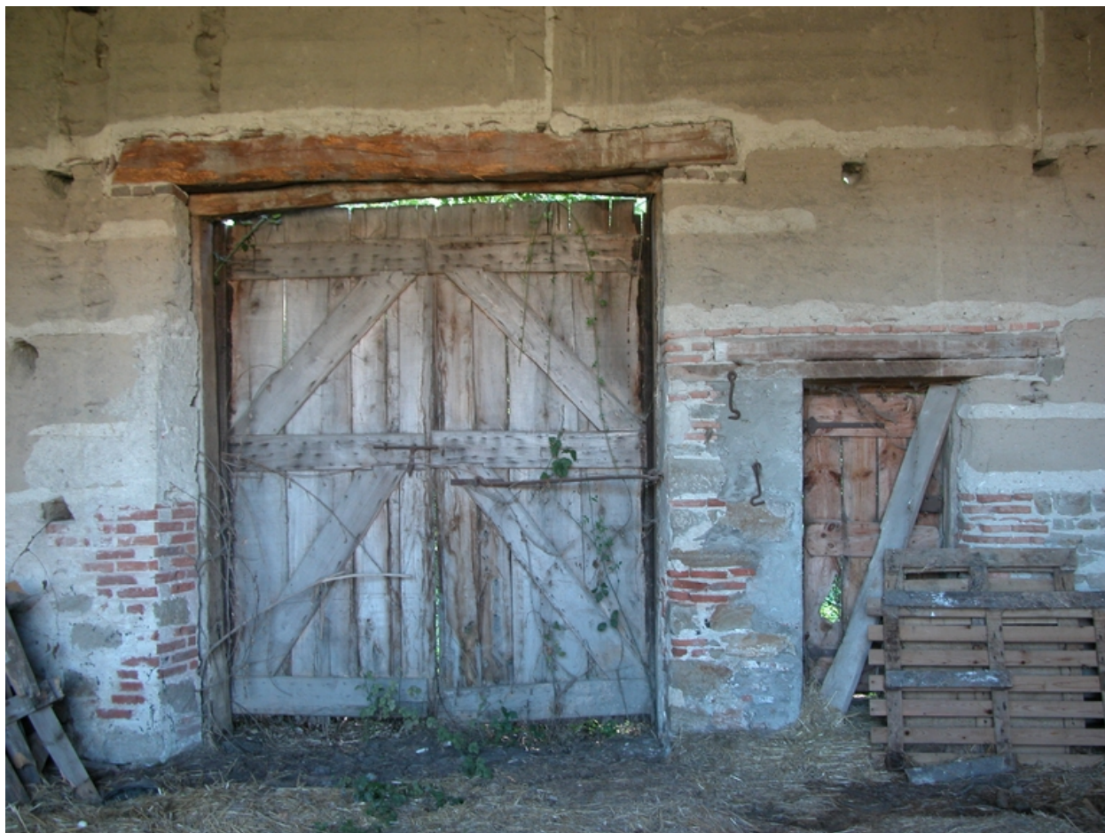
Vue intérieure de la partie grange-remise.
