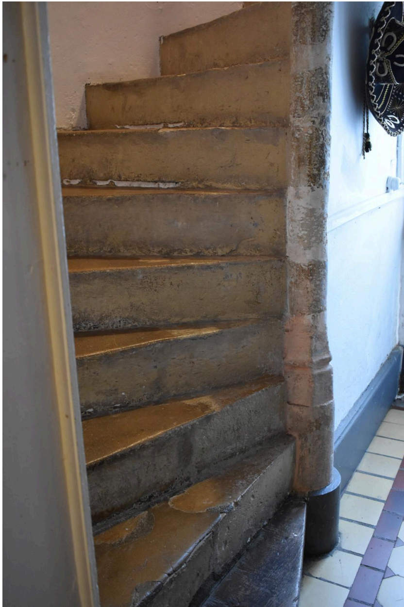
Vue de l'escalier en vis.
