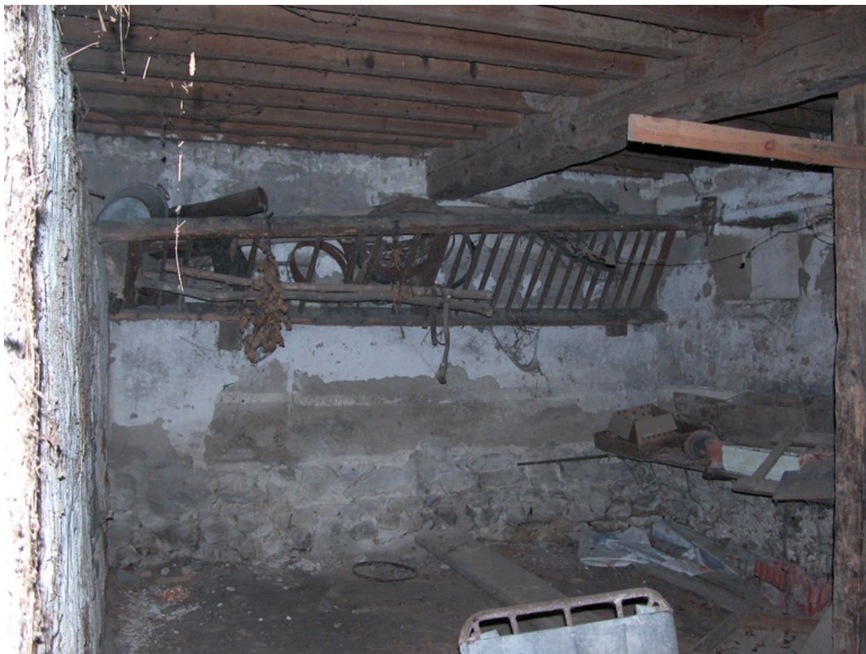
Vue intérieure du rez-de-chaussée : étable sud.
