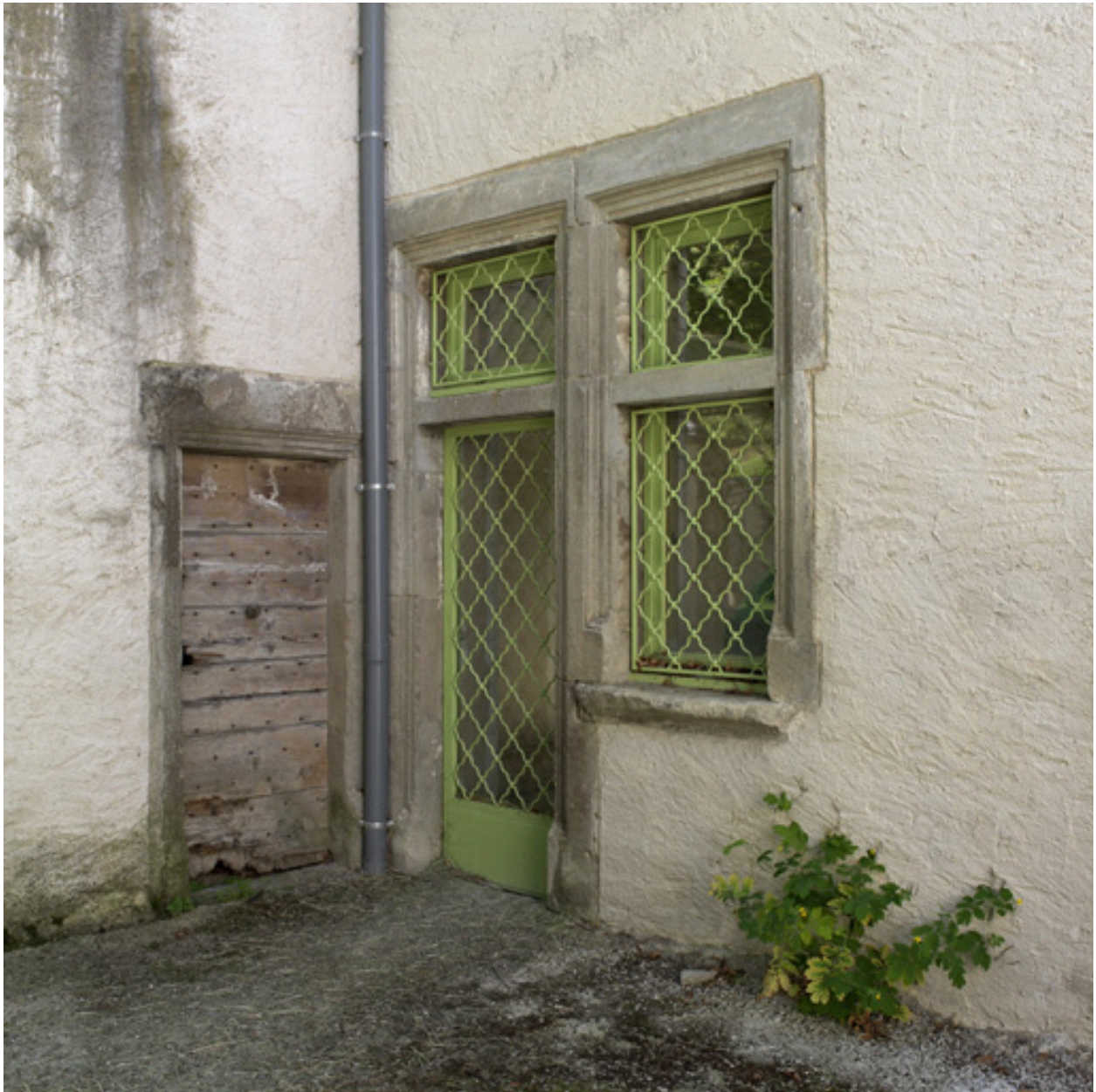
Façade nord : porte de la salle ouest du rez-de-chaussée surélevé et porte (murée) de l'escalier en vis.
