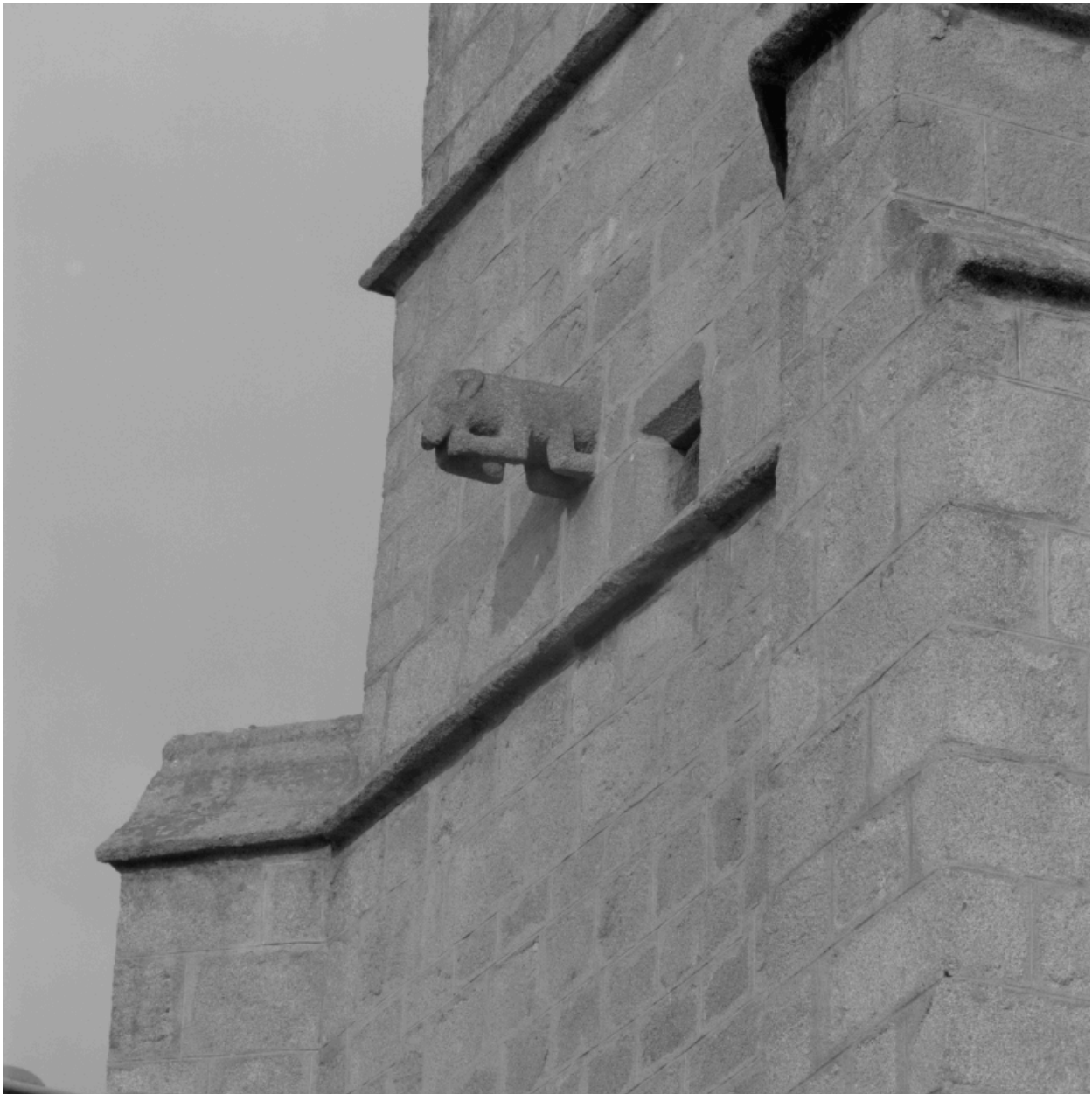
Détail d'une gargouille du clocher.
